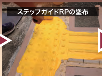
② 硬化剤を混合したステップガイドRPをペイントローラーで塗布します。
