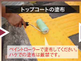
③ すみやかにマスキングを除去し、ステップガイドRPの硬化を確認後、硬化剤を混合した透明硅砂入りトップコートをペイントローラーで塗布します。すぐに透明硅砂を点字表面に機械散布等で直接散布し、すべり抵抗値が高くなる防滑処理をします。
