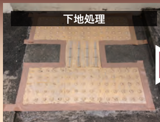
① 路面を清掃後マスキングします。
