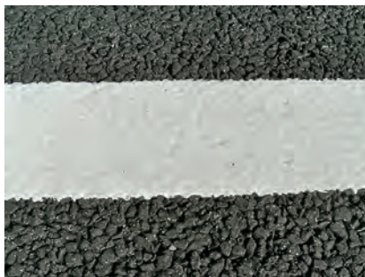
塗膜外観(通常ラインと同じ)
