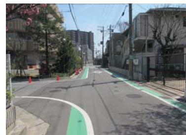
歩行者と車両の分離(兵庫県西宮市)
